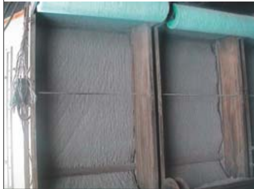
Filtre à air colmaté
