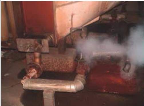
Fuite d'une gaine
