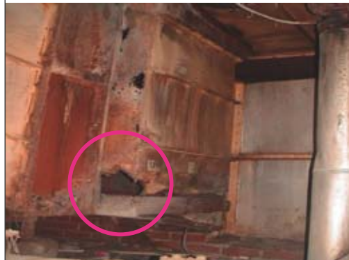
Corrosion dans l'échangeur de chaleur
